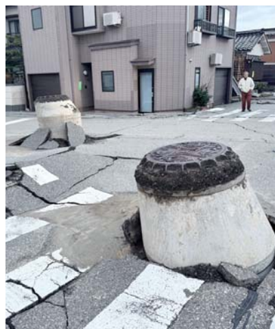
能登半島地震では下水道施設にも大きな被害が発生した
