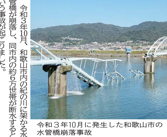
令和3年10月に発生した和歌山市の水管橋崩落事故
