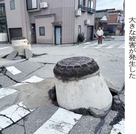
能登半島地震では下水道施設にも大きな被害が発生した
