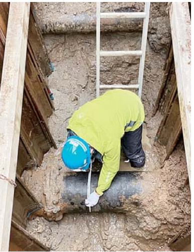
水道管の耐用年数は、約50年です。水道管の耐用年数は、約50年です。水道管の耐用年数は、約50年です。水道管の耐用年数は、約50年です。
