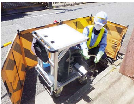
下水道管内をカメラ調査
