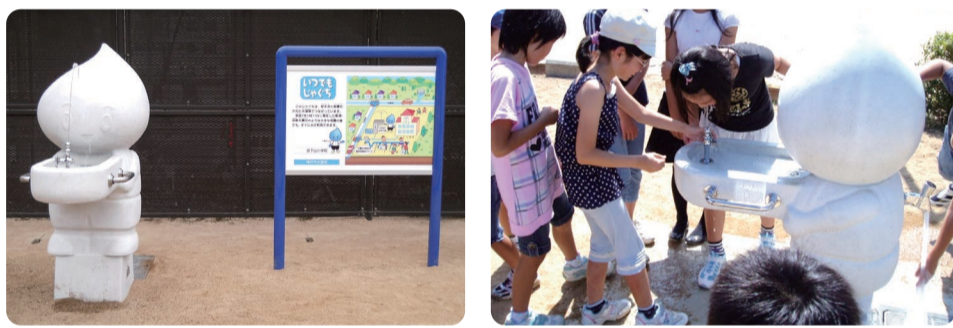
普段は水飲み場、災害時には給水栓として使える「いつでもじゃぐち」
