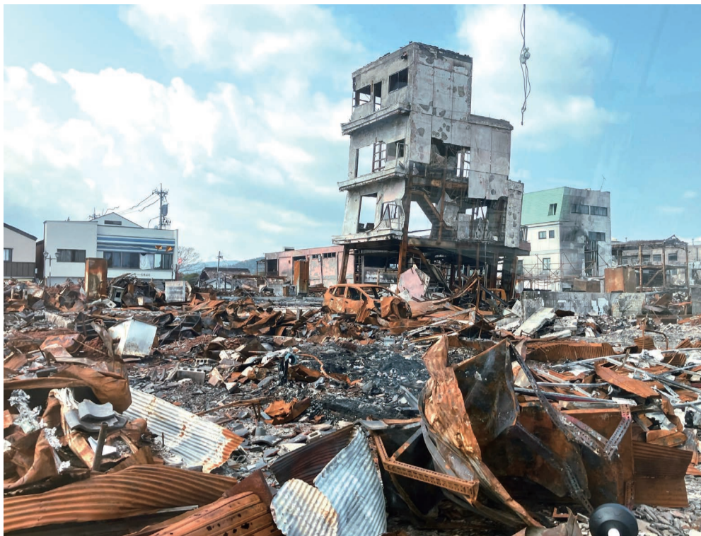
大きな被害を受けた輪島市
