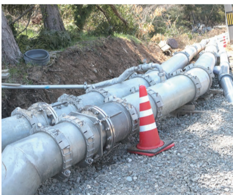
早く水を使えるよう、一時的に地面の上に水道管を通して様子
