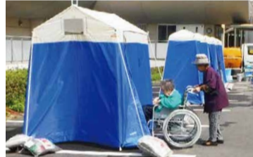
熊本地震で使用されたマンホールトイレ (提供: 熊本市上下水道局)
