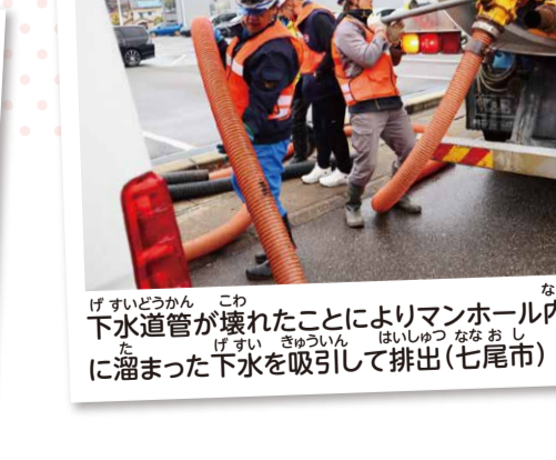
下水道管が壊れたことによりマンホール内部に溜まった下水を吸引して排出 (七尾市)
