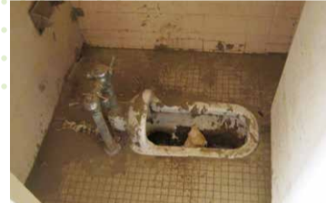
東日本大震災により水洗機能を失った和便器 (提供: 特定非営利活動法人日本トイレ研究所)
