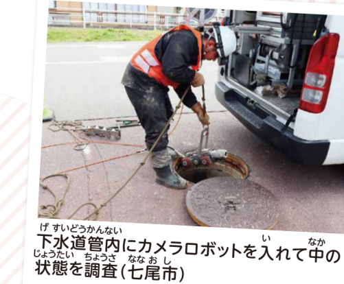
下水道管内にカメラロボットを入れて中の状態を調査 (七尾市)
