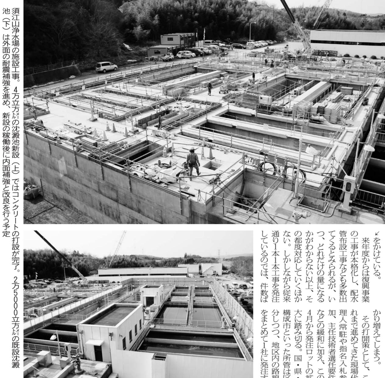
須江山浄水場の施設工事。下は外側の耐震補強を進め、新設の移動後に内面補強や改修を行なう予定。4万立方メートルの沈殿池新設(上)ではコンクリートの打設が完了。2万5000立方メートルの既設沈殿池(下)は外側の耐震補強を進め、新設の移動後に内面補強や改修を行なう予定。
