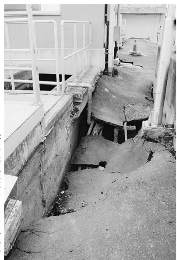
蛇田浄水場は壊滅化によりクラックが発生
