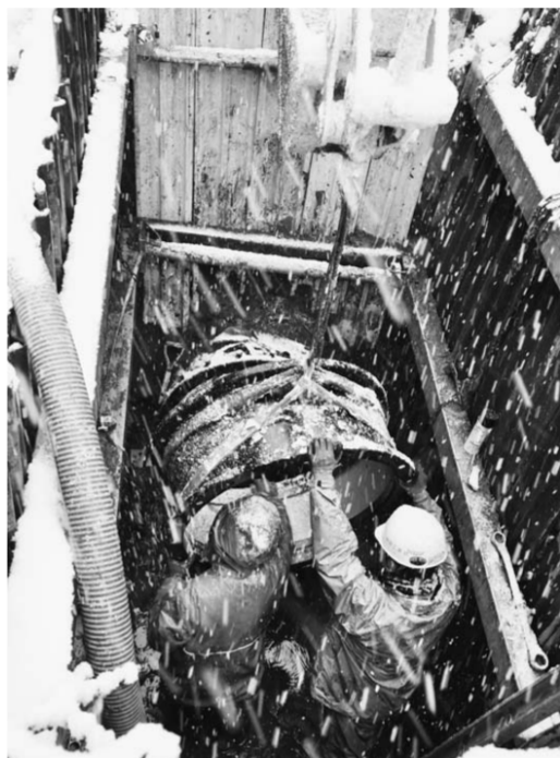
応急復旧には最大で33班が出動。雪が降る中で懸命な作業が続けられた
