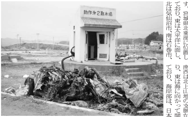
助作第2取水場の様子
