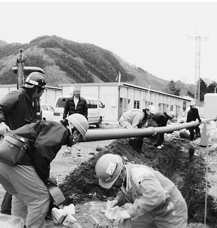
仮設住宅への応急給水配管(釜石市)
