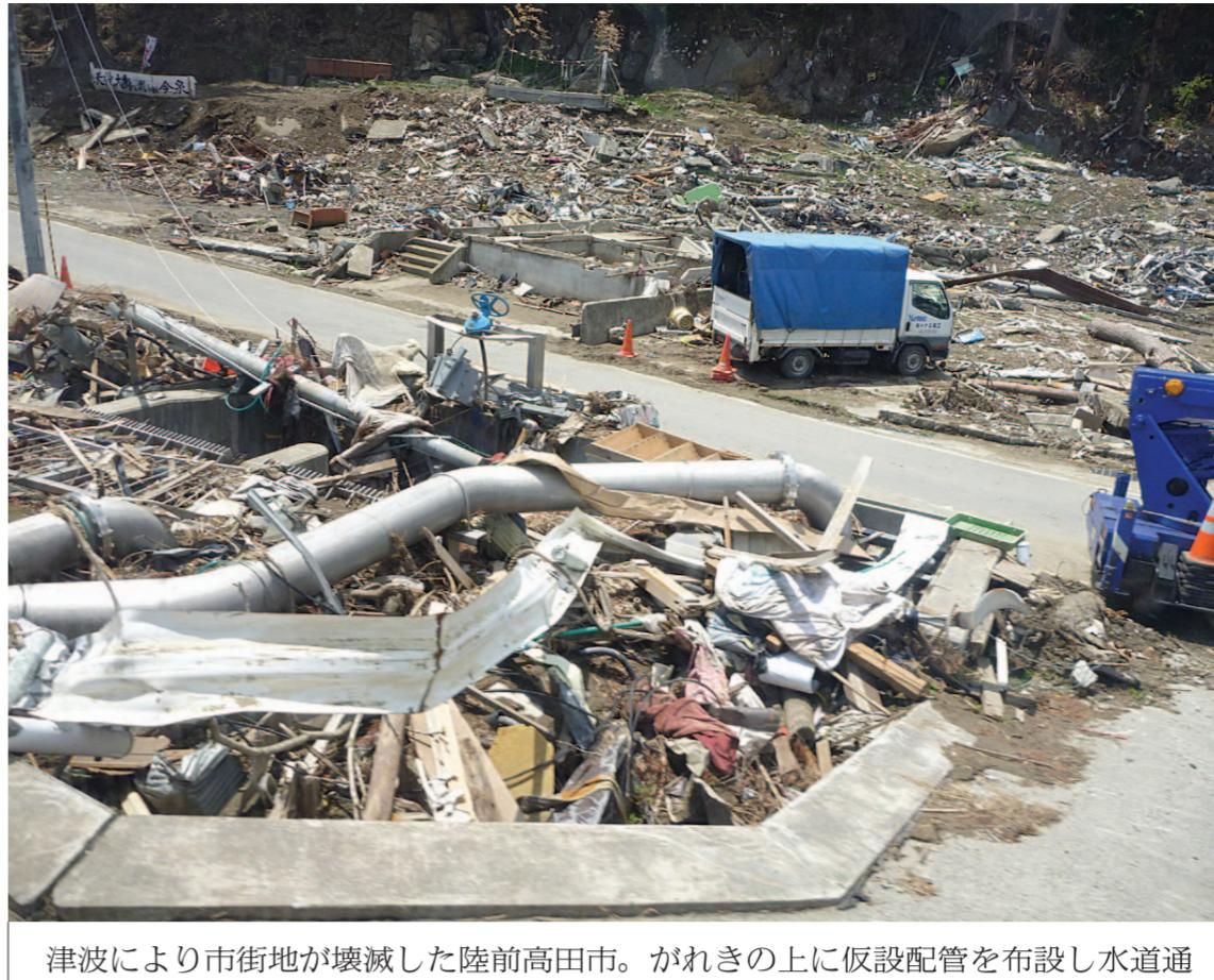
津波により市街地が壊滅した陸前高田市。がれきの上に仮設配管を布設し水道通水を急ぐ
