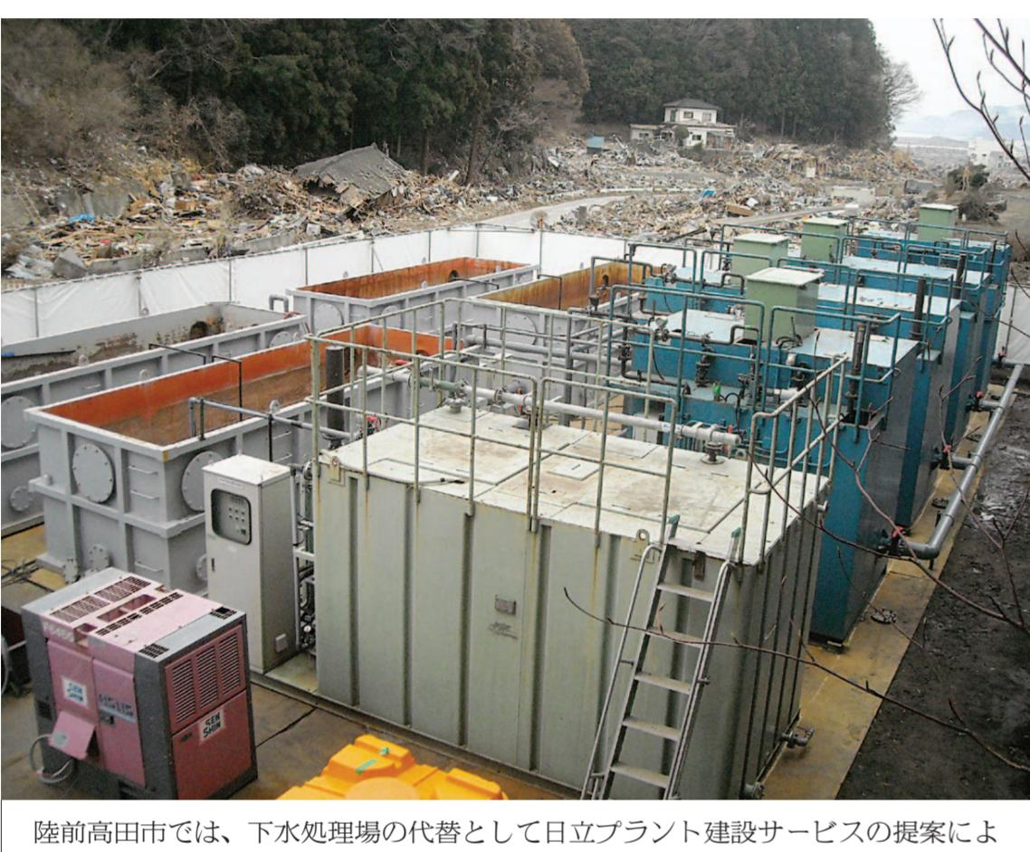
陸前高田市では、下水処理場の代替として日立プラント建設サービスの提案により緊急対策としてMBRプラントを導入、同市鳴石地区で応急汚水処理を実施
