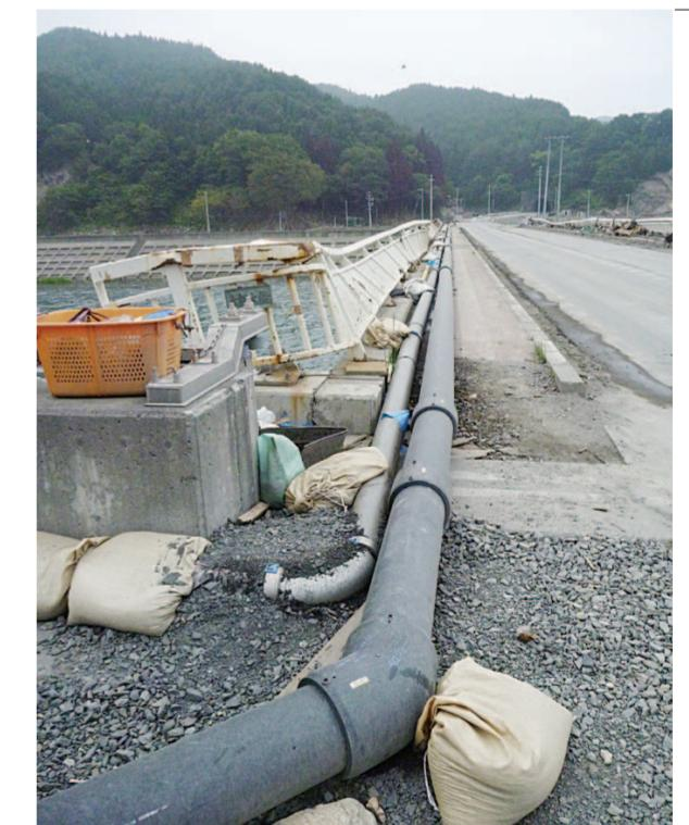
津波により管路に甚大な被害が発生したもの、浄水施設が無事だった大槌町では、仮設配管により迂回ルートを構築。山間部の津波被害を受けなかつた地域への通水を実現した
