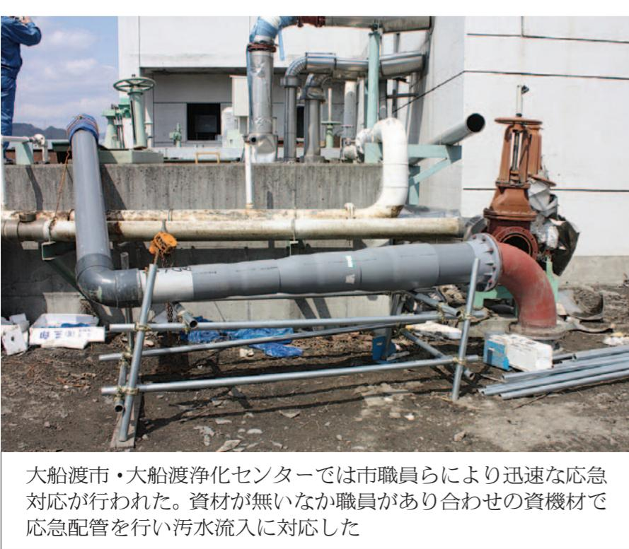
大船渡市・大船渡浄化センターでは市職員らにより迅速な応急対応が行われた。資材が無いなか職員があり合わせの資機材で応急配管を行い汚水流入に対応した
