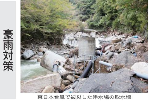
東日本台風で被災した浄水場の取水堰
