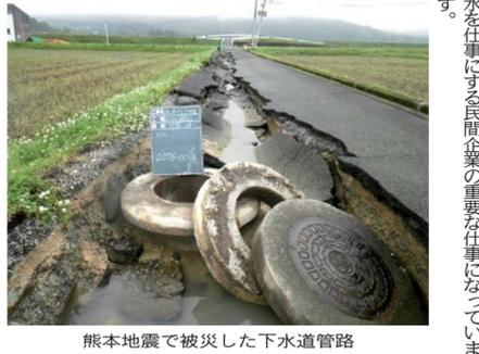
熊本地震で被災した下水道管路
