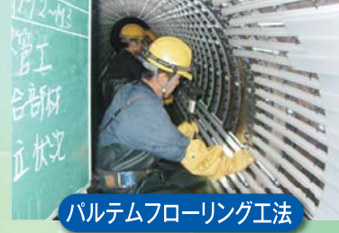
バルサムフローリング工法
