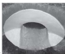
マンホールの 管口止水
