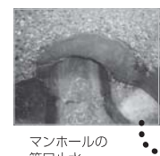
マンホールの 管口止水
