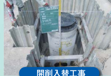
開削入替工事
