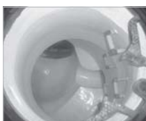
マンホールの 管口止水
