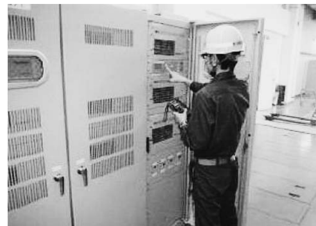
電気設備の点検
