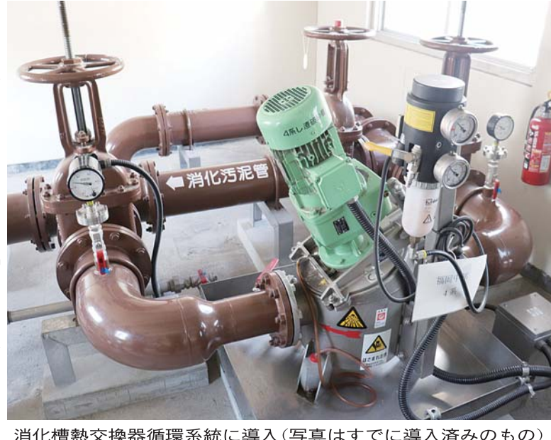
消化槽熱交換器循環系統に導入(写真はすでに導入済みのもの)
