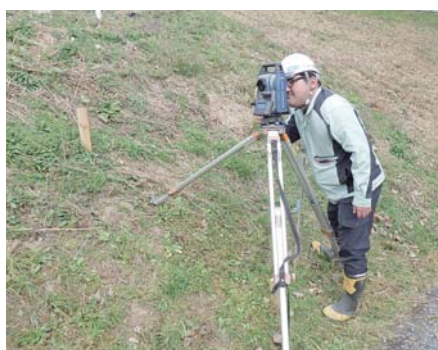
■特殊な技術で 会社は手に学びの場を広く提供してくれま。社員も、入社直後の設計部門、現場配属後の年間に東京支店へ1年間の出向、上下水道関係だけでなく、橋梁など、さまざまな現場で活躍しています。いかに現場に入るの戸惑いも、分らないことを聞けるベテランの指導、困ったことや大変なことを話せる同僚がいるので、やる気があれば大抵のことには大丈夫。経験は積んで自身も成長させていきたいです。
